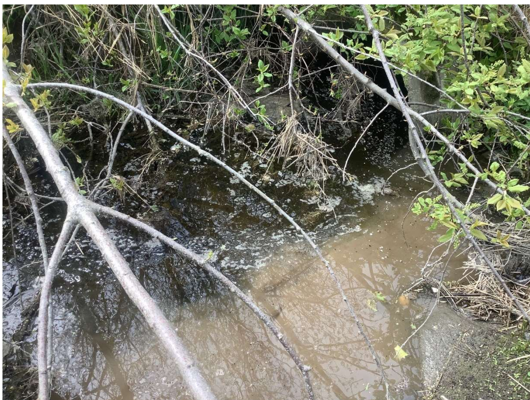
Figur 2-6: Utløpet av den øverste kulverten. En ser at utløpet er delvis dukket og kulverten er derfor mest sannsynlig utløpskontrollert.
