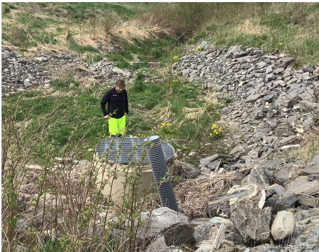
Figur 2-5: Nytt innløpsarrangement for den øverste kulverten.
