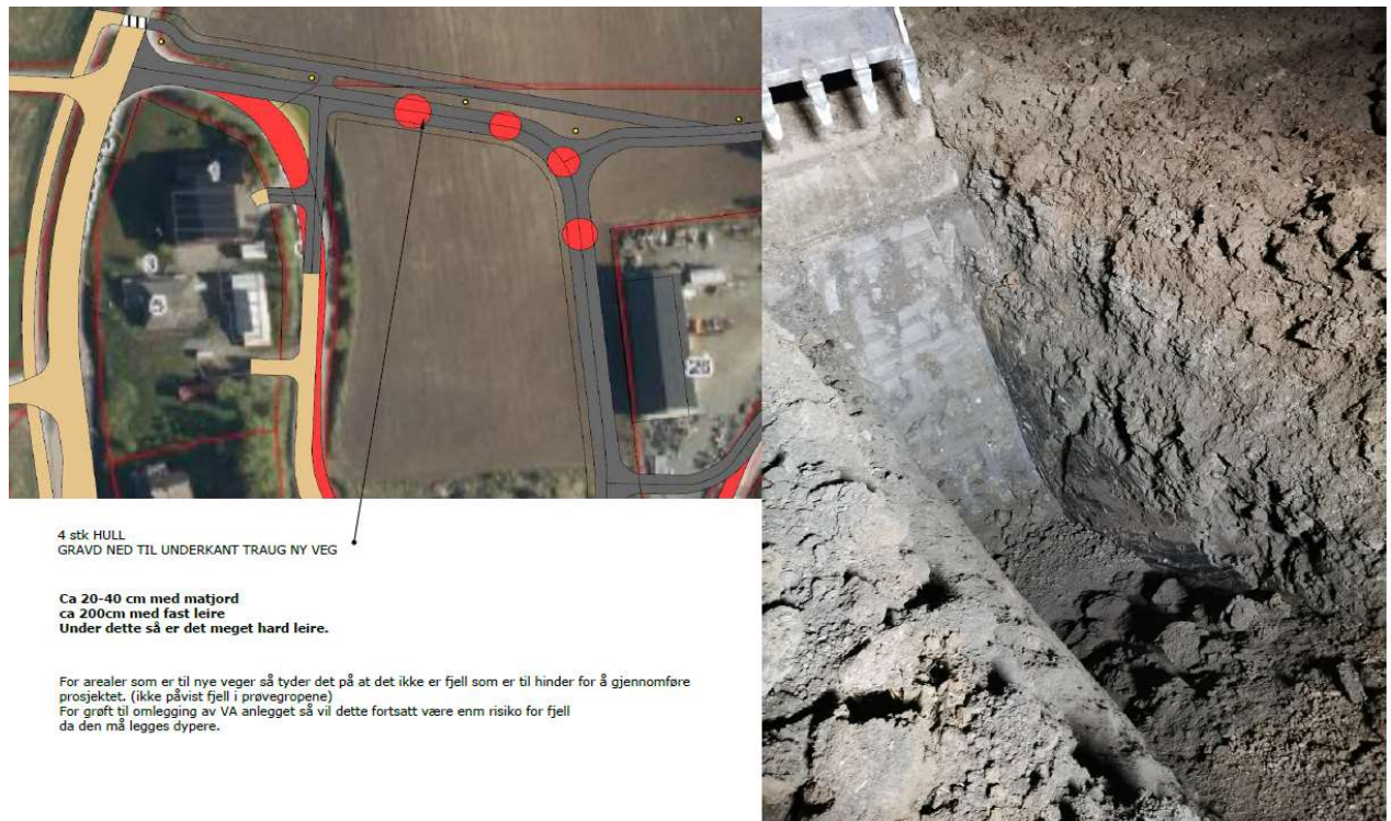
Figur 2-1: Bilder og beskrivelse av prøvegraving utført av AZ Gartner AS
