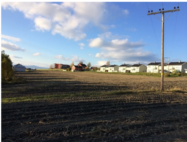
Bildet viser høgspenningslinje i luftlinje.
